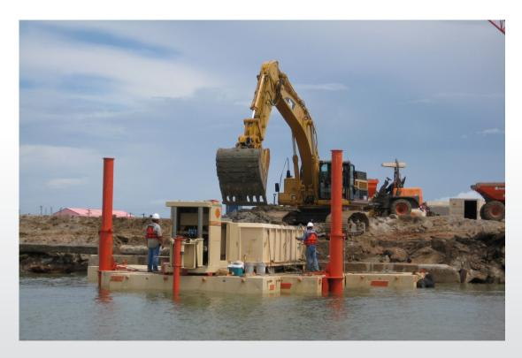
INTEGRAL BARGE TO BARGE LOCKING ASSEMBLY
